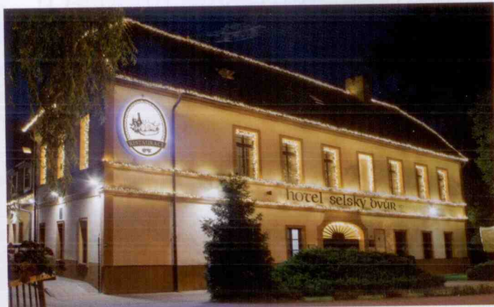
Kuchyně hotelu Selský Dvůr prošla kompletní rekonstrukcí.
